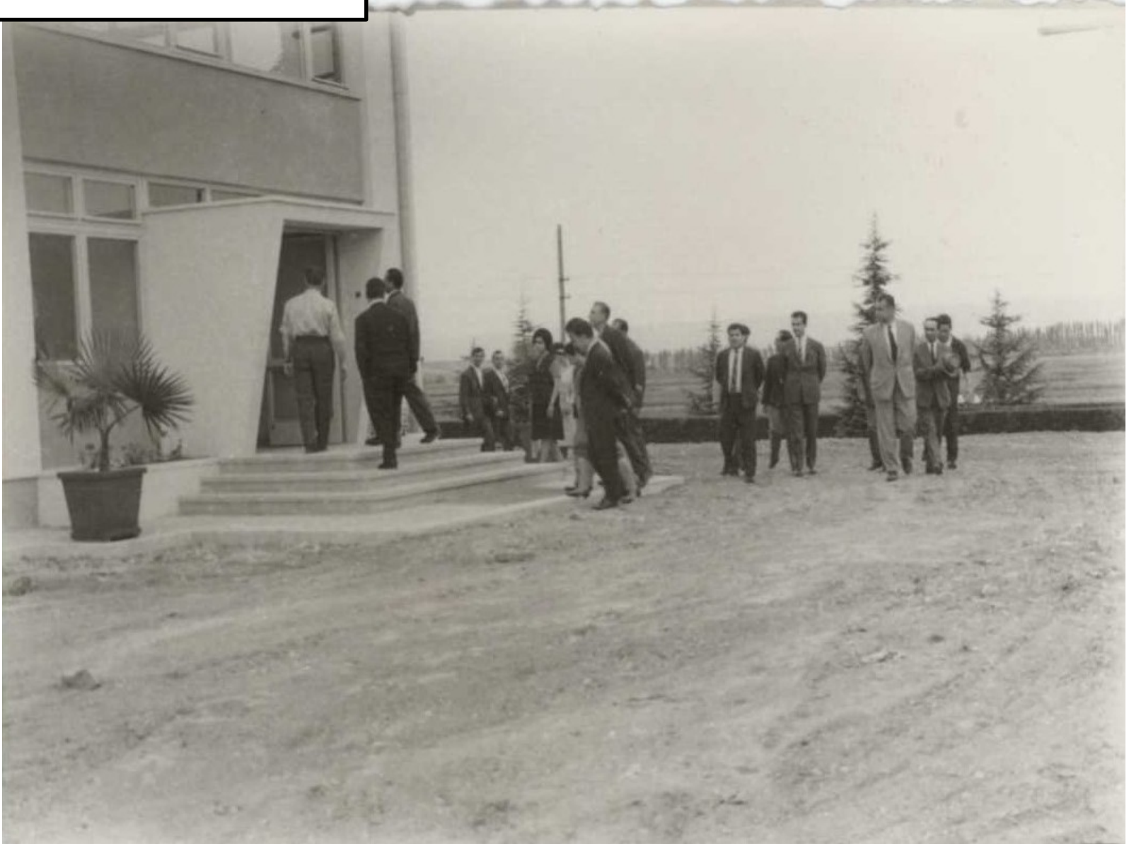
Rıfat Gerek Binası
